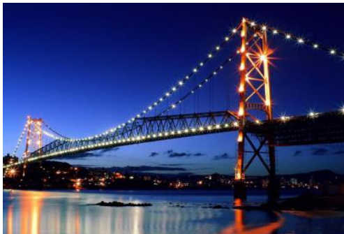
Hercílio Luz Bridge
